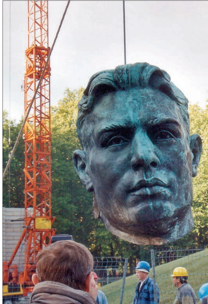
Um den Rotarmisten vom Treptower Ehrenmal restaurieren zu können, musste er in seine Einzelteile zerlegt werden. Foto: Caspar
